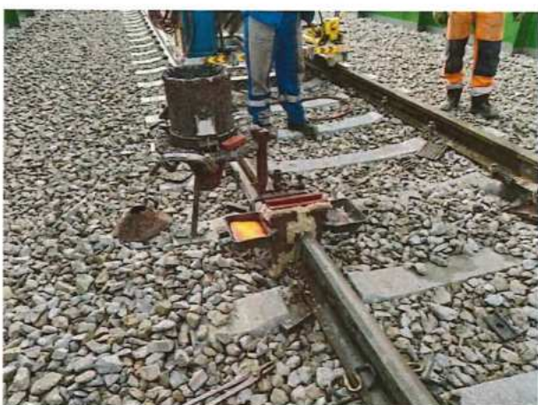
Zváranie koľajníc do bezstykovej koľaje, UČS 12
