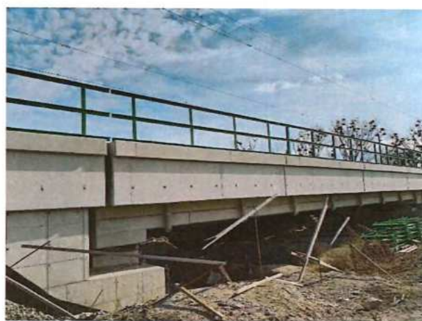
Montáž zábradlí na moste SO 12-33-01
